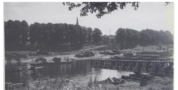
Britische Soldaten beim Bau der sogenannten „Bailey-Brücke“ über die Weser anstelle der zerstörten Weserbrücke im April 1945.
