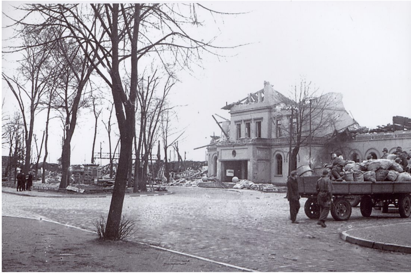
Das Empfangsgebäude des Nienburger Bahnhofs im April 1945, kurz nach der Zerstörung durch die Explosion eines Munitionszuges nach einem Bombenangriff.
