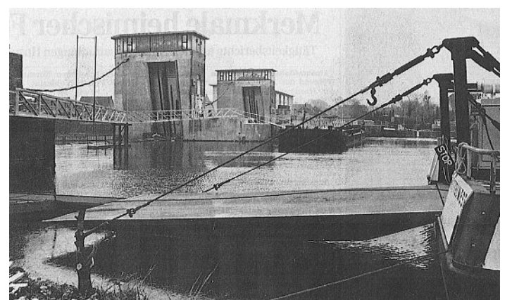
Das Weserwehr während des Umbaus 1996.
