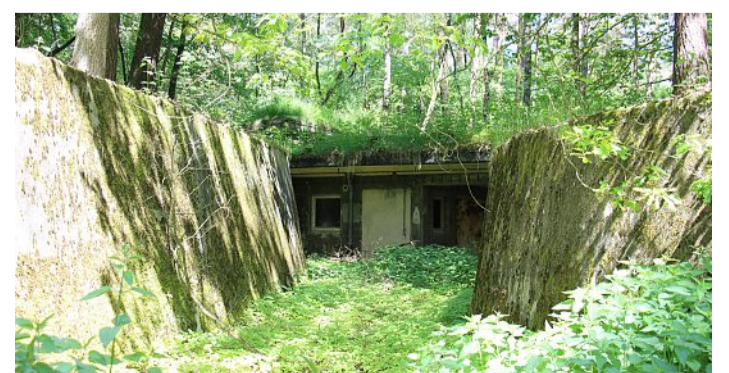
Das ehemalige Trockenhaus ist fast zugewuchert.
