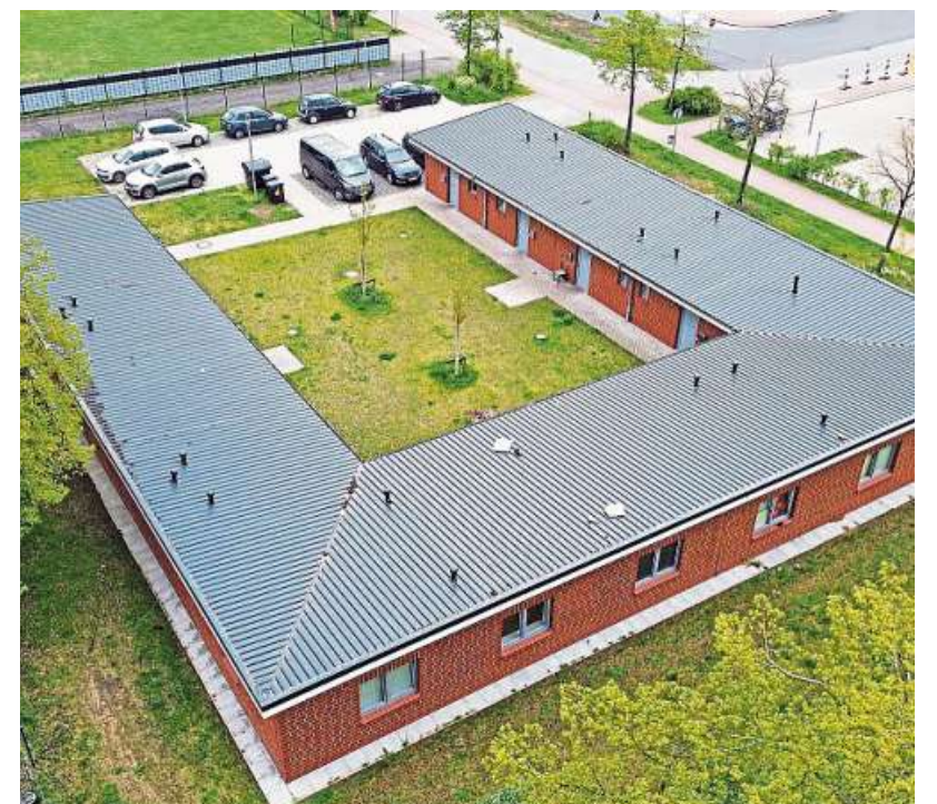
In der Nienburger Obdachlosenunterkunft gibt es zwölf kleine Wohnungen sowie eine Notschlafstelle für maximal vier Personen.
