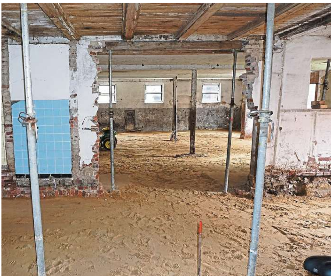
So sah es zwischendurch aus: Die alte Scheune wurde komplett entkernt.
