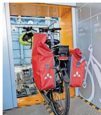
Von einer Schiene wird das Rad durch eine Aufzugtür in den Biketower geschoben und dann geparkt – niemand kann das Gebäude betreten.
