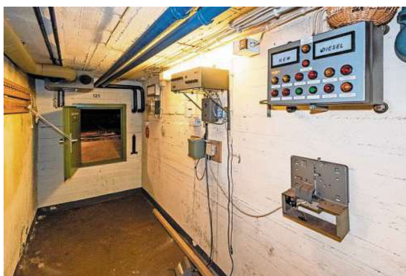
Kontrolle: Im Zimmer des Bunkerwarts wurden Anlagen überprüft.
