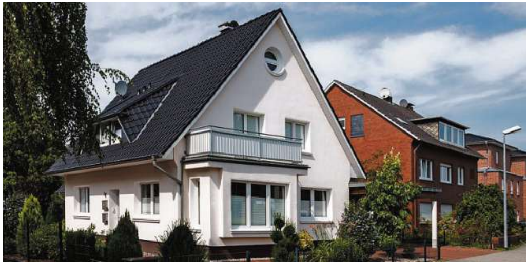
Wärme schützen und Energie effizient nutzen: Die Dämmung der Außenwände schafft in Bestandsgebäuden die Voraussetzung dafür, auf moderne und effiziente Heizsysteme umsteigen zu können. Foto: stock.adobe.com/Ms VectorPlus
