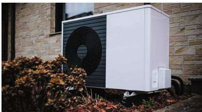
Wärmepumpen lassen sich in älteren Gebäuden erst dann wirklich effizient betreiben, wenn gedämmte Außenwände die Wärme schützen. Foto: stock.adobe.com/Robert Poorten
