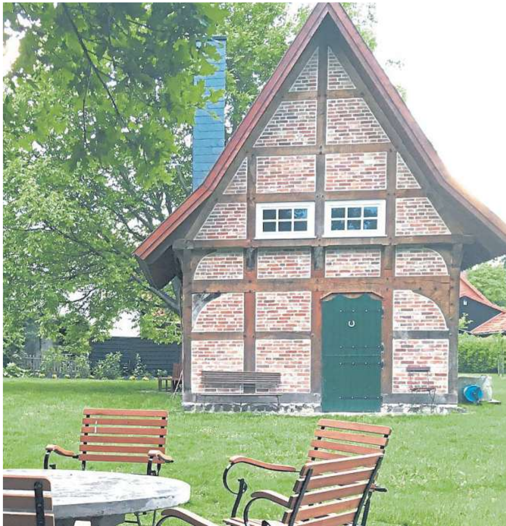
Wird während der 20-Jahr-Feier von „Witten Hus“ am nächsten Sonntag offiziell eingeweiht: der im frühen 17. Jahrhundert in Wietzen errichtete und vom Heimatverein in Liebenau als „Hochzeitschmiede“ wieder aufgebaute alte Fachwerkspeicher.
