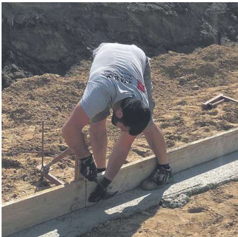
Viele Schritte sind bis zur Fertigstellung eines neuen Hauses notwendig. Die Firma V.M Bau verfügt über ein großes Leistungsspektrum. Foto: V.M Bau
