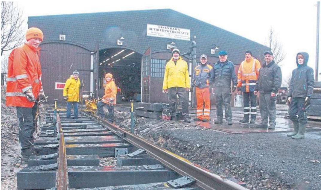
Auf dem Bahnhofsgelände wird vor der Fahrzeughalle ein Bahnkörper von 50 Meter Länge erneuert. Die neuen Kunststoffschwelle...
