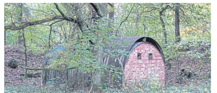
Die alten Munitionsbunker verfallen nach und nach zwischen ihren Erdwällen. Für einen Abriss fehlte die finanzielle Bewilligung.
