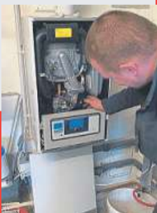
Wartung und Dienst am Kunden: Die Anforderungen im Heizungs- und Sanitärbereich haben Stück für Stück zugenommen. FOTO: TESSNER
