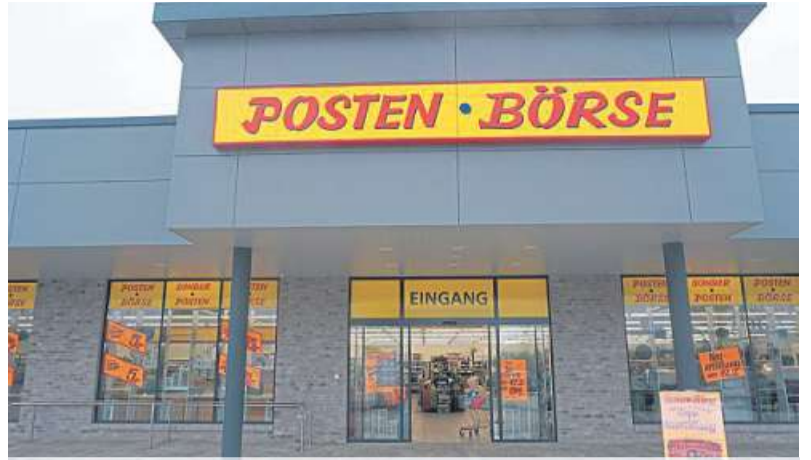
Die Investitionskosten für den Neubau an der Bürgermeister-Heuemann-Straße lagen bei eineinhalb Millionen Euro. FOTOS: GRAUE
