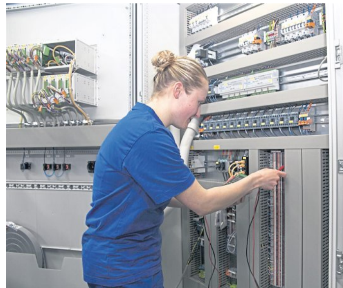
Eine Elektronikerin sucht nach dem Ausfall einer Telefonanlage den Fehler.
