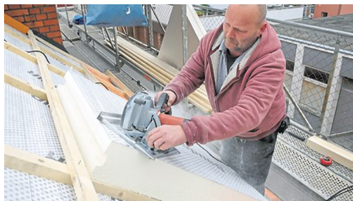
Ein Dachdecker schneidet Dämmplatten mit der Handkreissäge zurecht.
