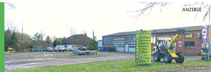
Es wird sich einiges tun auf dem Firmengelände an der Mindener Straße: Die bestehende Halle wird saniert, eine weitere neu gebaut, außerdem der Hof gepflastert.
