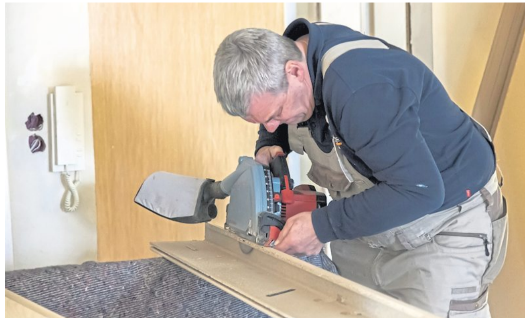
Ein Tischler sägt beim Einbau einer Türzarge eine Kante zurecht.
