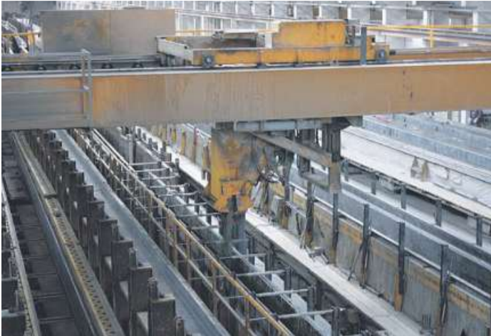
Beton wird maschinell in eine Form gegossen.
