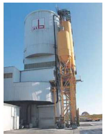
Gute 40 Meter misst der Mischturm auf dem Betriebsgelände.
