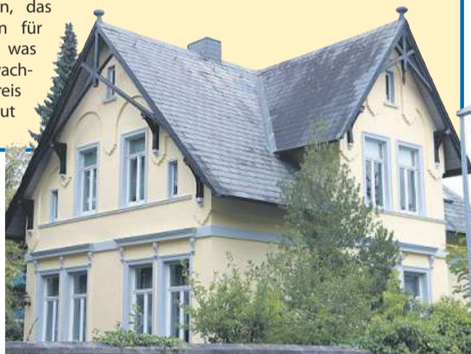
Bei diesem Haus von 1892 hat der Malerbetrieb Disli die komplette Fassade in etwa zwei Wochen saniert.
