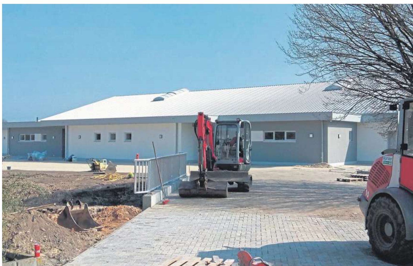
Viel ist nicht mehr zu tun an der neuen Halle. Die Außenarbeiten sind weitestgehend abgeschlossen.
