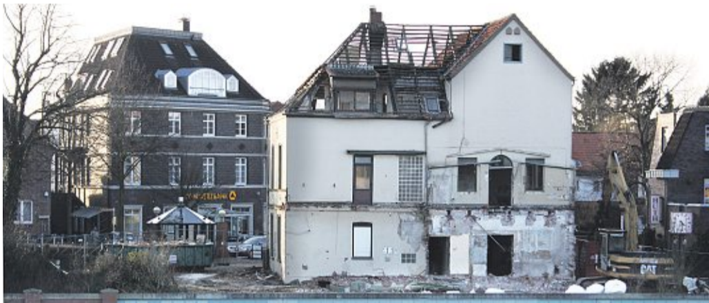
Das Haus Wentzlau während der Abrissarbeiten von der Weserseite aus fotografiert.
