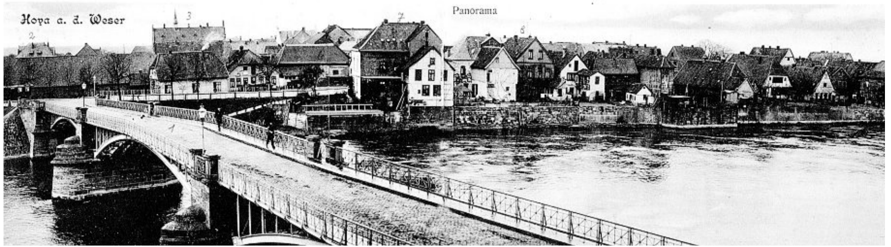
Das obige Panorama-Foto aus dem Jahr 1910 zeigt das Haus im Hintergrund, mit der im Jahr 1881/1882 gebauten Weserbrücke, aus dem umfangreichen Archiv von Henry Meyer in Hoya.
