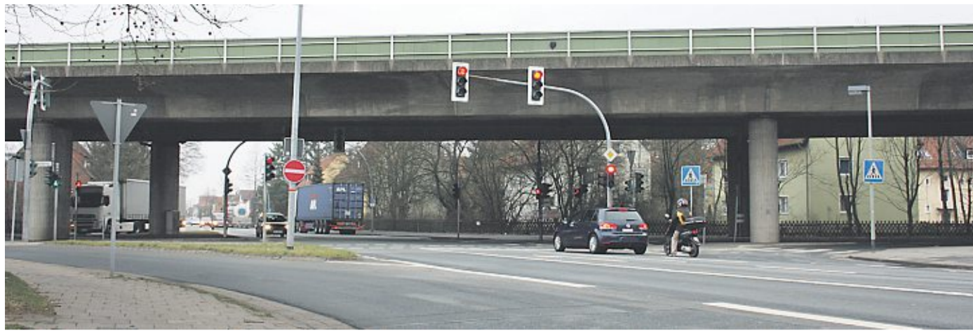
Ab morgen ist die Kreuzung „Verdener Landstraße / Nordring“ wegen des Kreiselnbaus komplett gesperrt. Radfahrer und Fußgänger können die Baustelle passieren. Archiv Duensing
