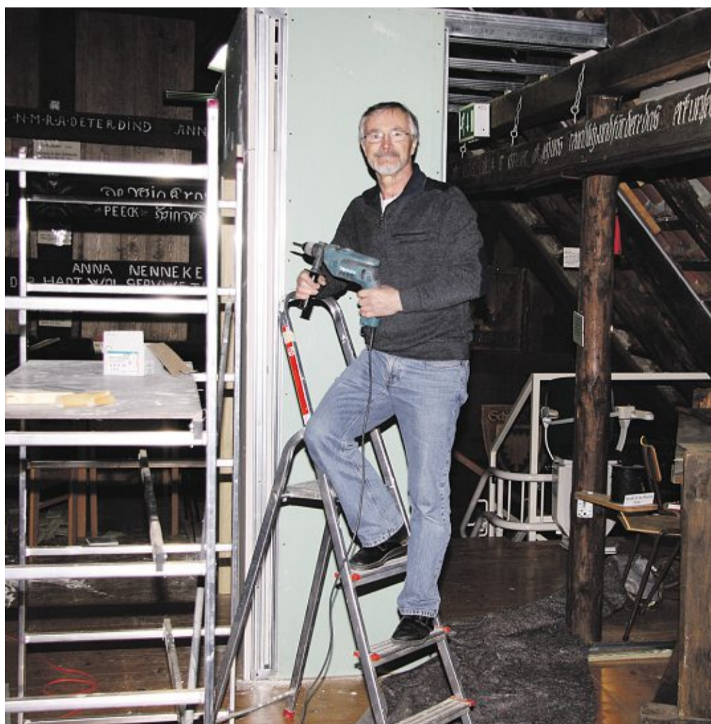
Museumsleiter Kurt Cholewa muss am neuen Treppenhaus noch etwas werkeln, der neue Lift (hinten) wurde bereits montiert. Jedamzik
