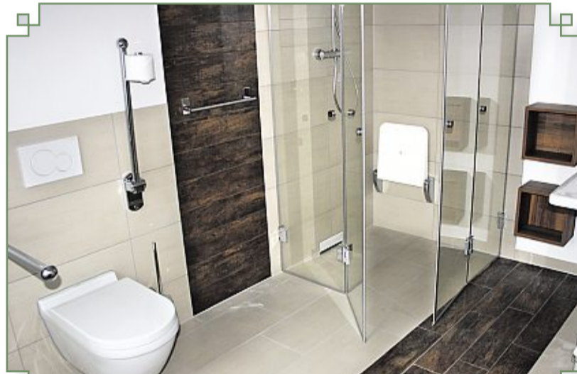
WC und Dusche sind behindertengerecht ausgestattet.
