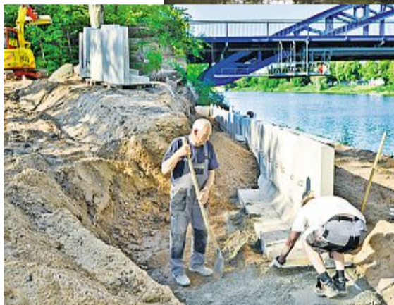
Die neue Fahrradrampe von der Weserbrücke aus gesehen. Ende Mai war damit begonnen worden, die maßgeschneiderten Winkelstützen zu setzen (kleines Foto), das neue Geländer wurde in der vergangenen Woche fertig. Fotos: Hagebölling
