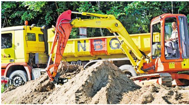
Für die neue Radfahrer-Rampe mussten auch etliche Kubikmeter Erde bewegt werden.
