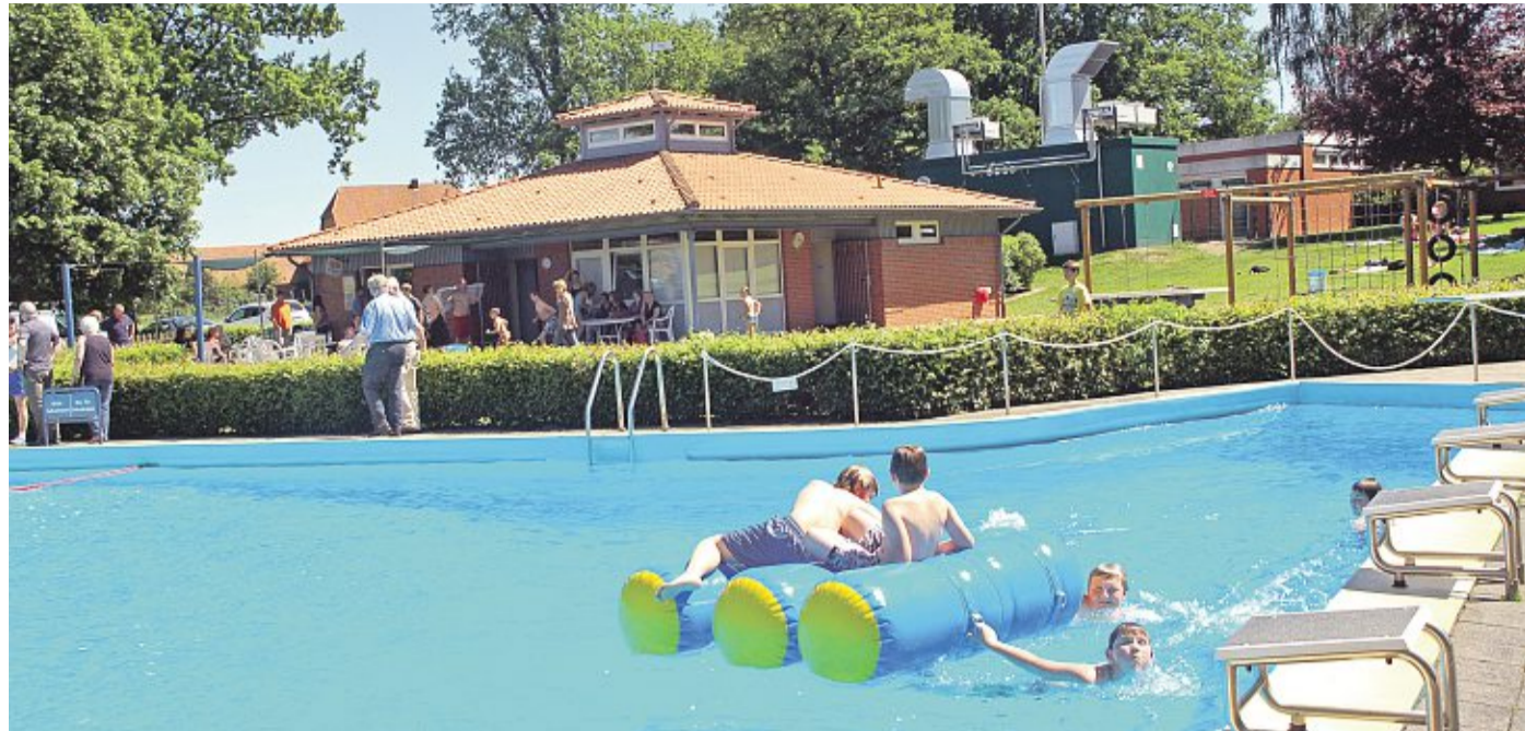
Badespaß bei 25 Grad im gestern eröffneten Freibad Wietzen: Das grüne Blockheizkraftwerk im Hintergrund liefert Biogas-Wärme für Bad und Haushalte.
