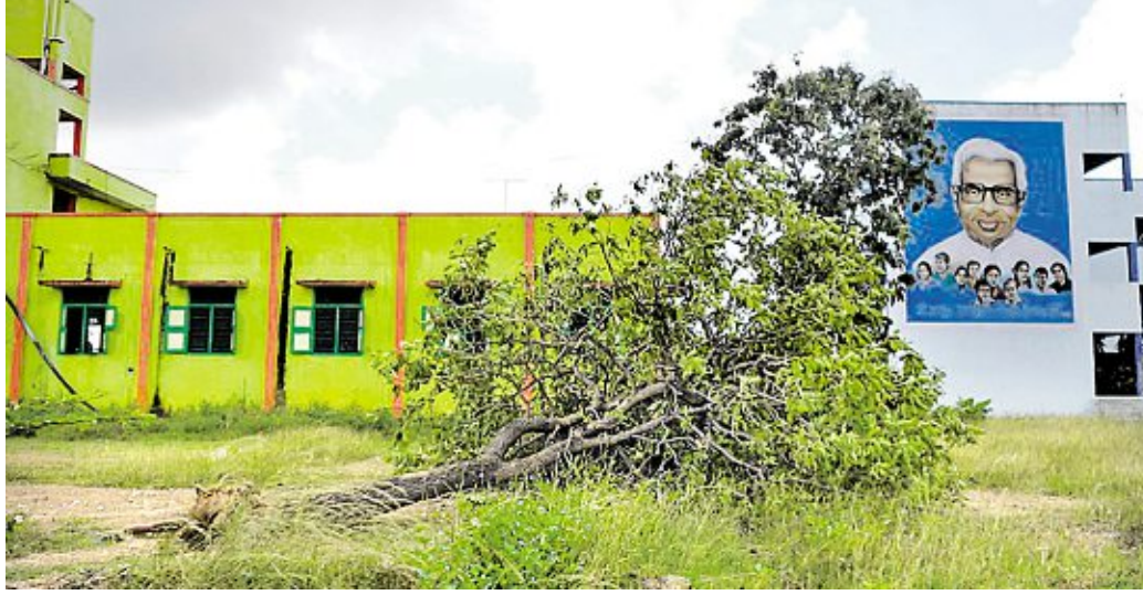
Auf dem Gelände der indischen Partnerschule wurden durch den Wirbelsturm Bäume entwurzelt und das Gebäude beschädigt.
